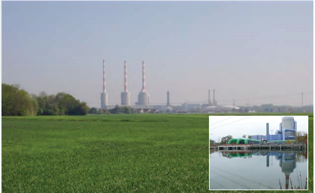
Abb. 1: Kraftwerksstandort Irsching mit Detail Einleitungsbauwerk
